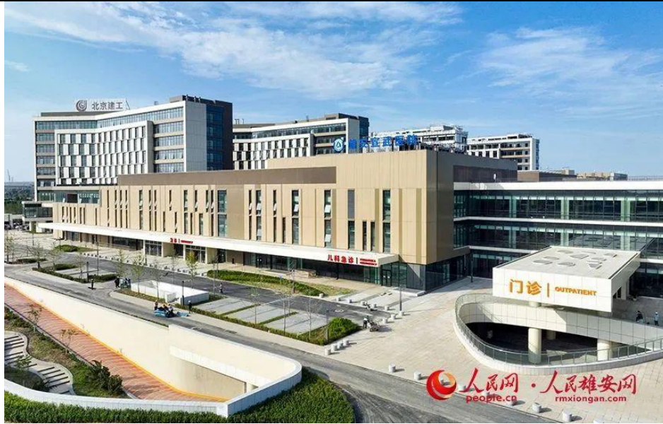
图 1.5-1 雄安宣武医院医疗区建筑图
